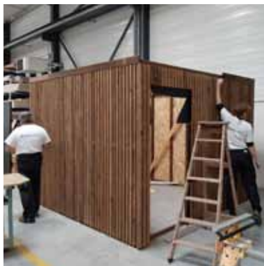
Montage d'ossatures bois
