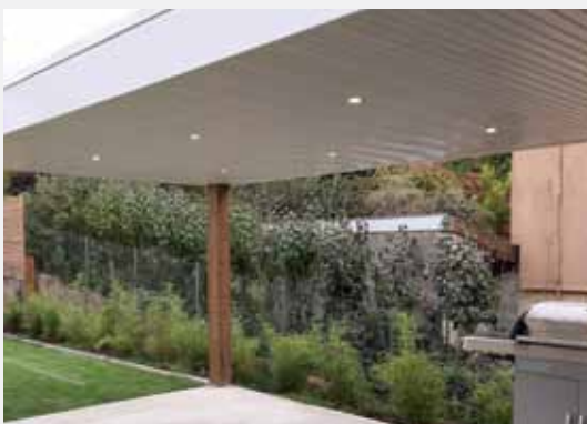
HABILLAGE DE LA SOUS-FACE ET DES BANDEAUX EN PVC
