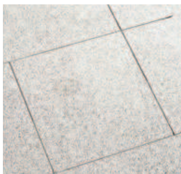
Dalles Arcadia® avec CleanTop® après le nettoyage.
