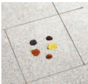
Dalles Arcadia® avant le nettoyage.
