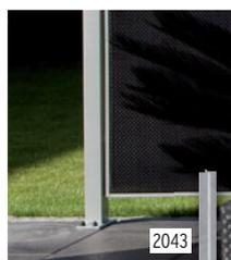
**Fixation au sol:** Sceller les poteaux directement dans la terre ou les raccourcir et à l'aide du support de poteau (2043) les cheviller sur une fondation.
